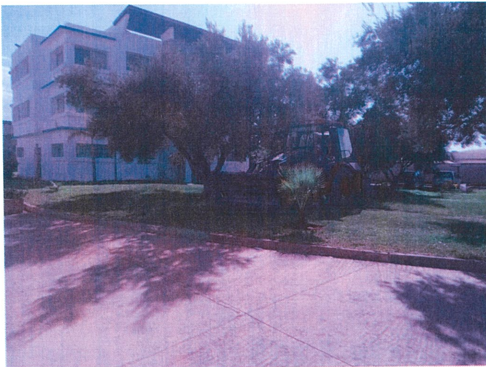
Photo-3- : Montrant les travaux de réalisation des sondages mécaniques
